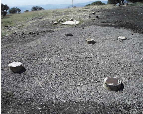
Şekil 14: ROTSE için hazırlanmış bir platformda 5 pilye görülüyor. ROTSE'nin kendi metal platformu bu pilyeler üzerine yerleştirilecektir.
