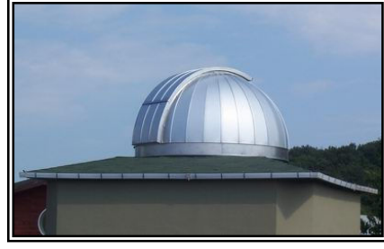
Şekil 1. YIEV Nahum Gözlemevi Kubbesi 12' 6" çapında REA model ash-dome kubbe
