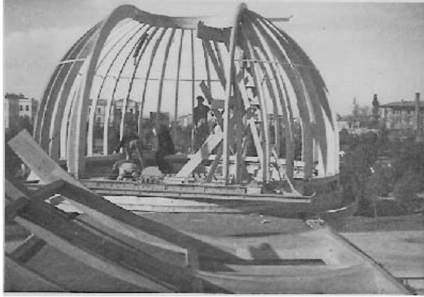
Şekil 3. 1935’li yıllarda İ.Ü. Gözlemevi kubbe inşaatı.
